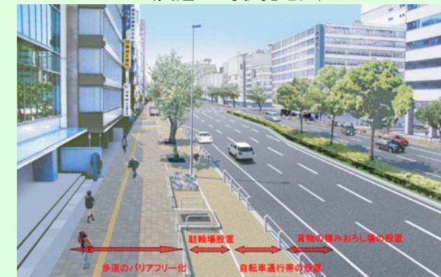
自転車と歩行者と車の通行を完全分離 (国道19号伏見地区)
