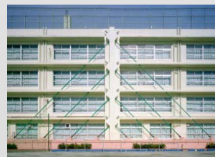
耐震補強工事をした小学校校舎
