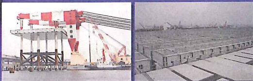
D滑走路棧橋構造
