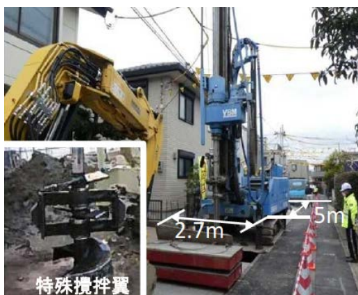
図-3 スマートコラム工法
