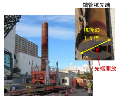
■STEP1 鋼管杭圧入・鋼管内コンクリート打設
