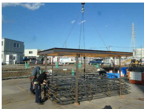
写真-2 帯鉄筋組立状況
