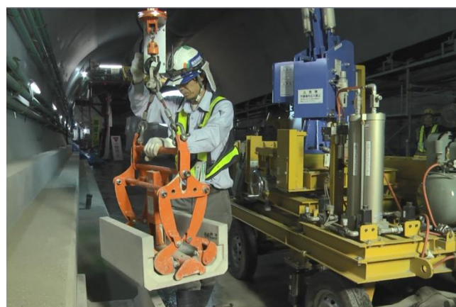
写真-1 施工状況
