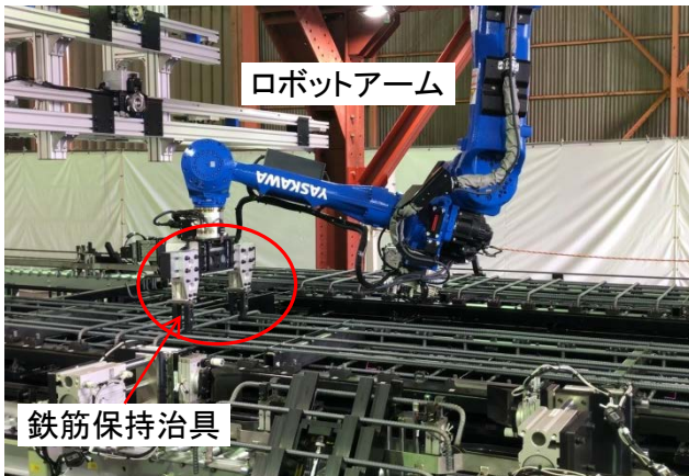
写真4 鉄筋配置作業の様子
