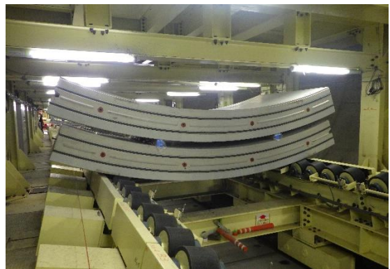
写真-2 後続台車セグメントストック装置
