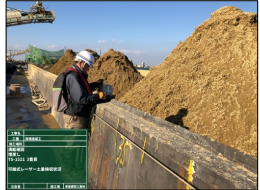
【土運船での検収状況】
