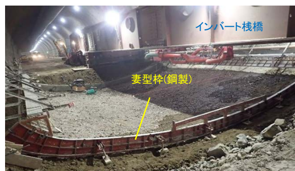
写真-2 妻型枠(鋼製仕様)
