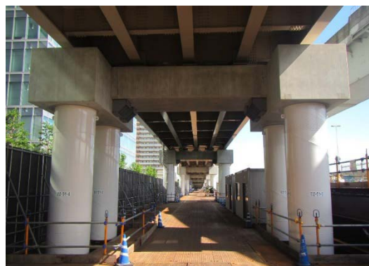
写真-1 高耐震性パイルベント橋脚
