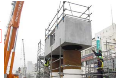
■STEP2 キャップ部架設・中詰コンクリート充填
