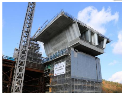
写真4 P6柱頭部（押し出し後）
