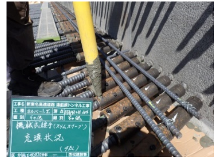
写真2 スリムスリーブ 施工状況(現場打ち部)
