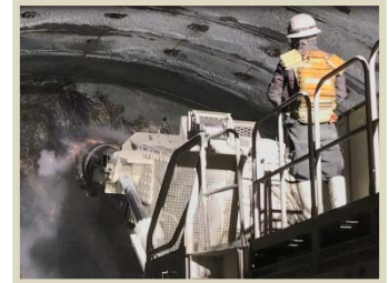
写真 3 硬岩部掘削状況
