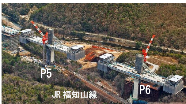
写真 1 生野大橋全景（施工中）
