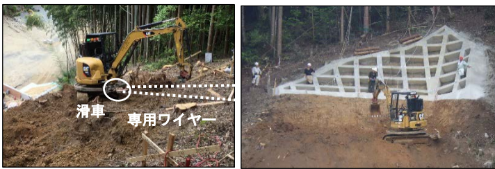
写真 1 セーフティクライマー工法による施工状況
