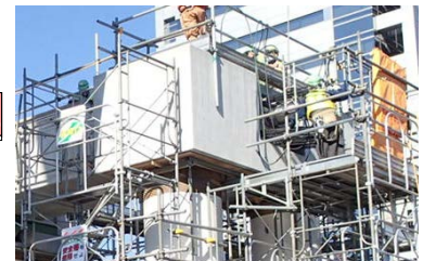
図-2 高耐震性パイルベント橋脚施工手順
