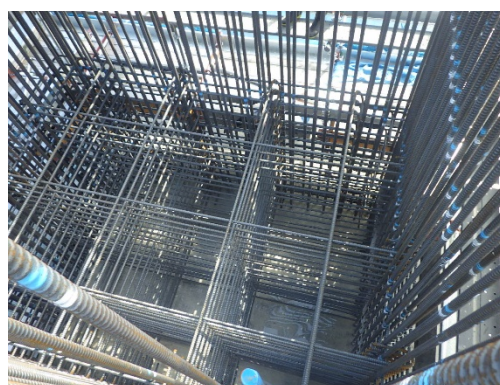
写真-4 配筋完了
