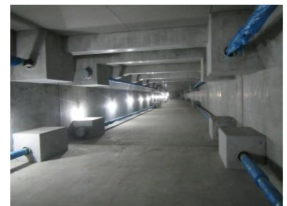
写真4 函体内の外ケーブル配置
