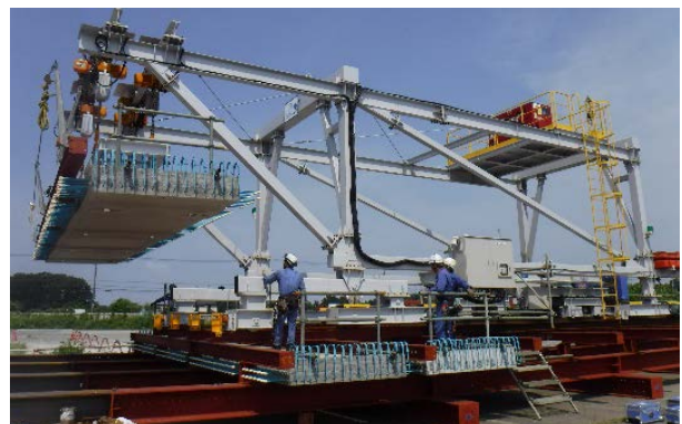
写真2 既設床版の縁切り・撤去作業
