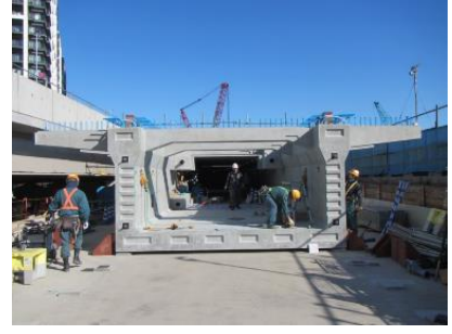
写真3 セグメント設置完了
