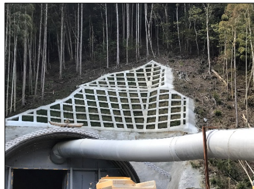
写真 3 切土法面施工完了
