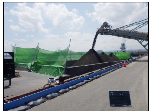
【土砂積込状況】
