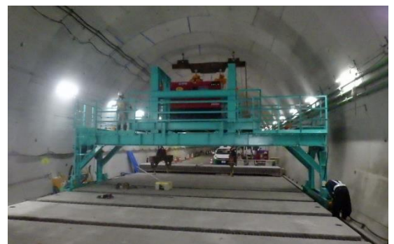
写真-4 PC床版 (ループ継手方式)
