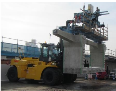
写真1 セグメント運搬
