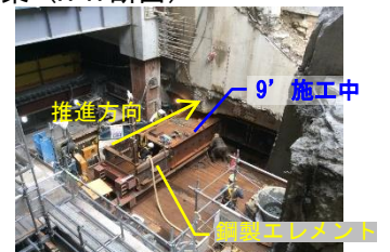
写真-4 推進状況
