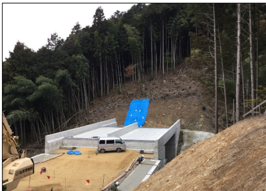
写真 2 切土法面着手前
