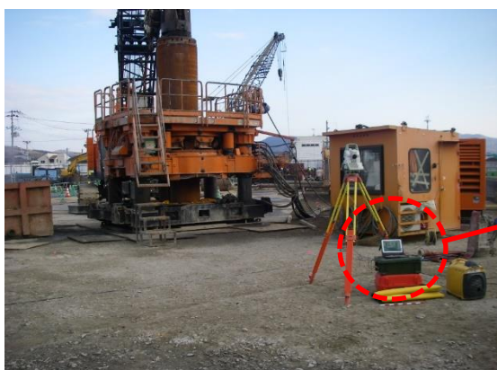
写真-1 場所打ち杭施工状況(管理状況)
