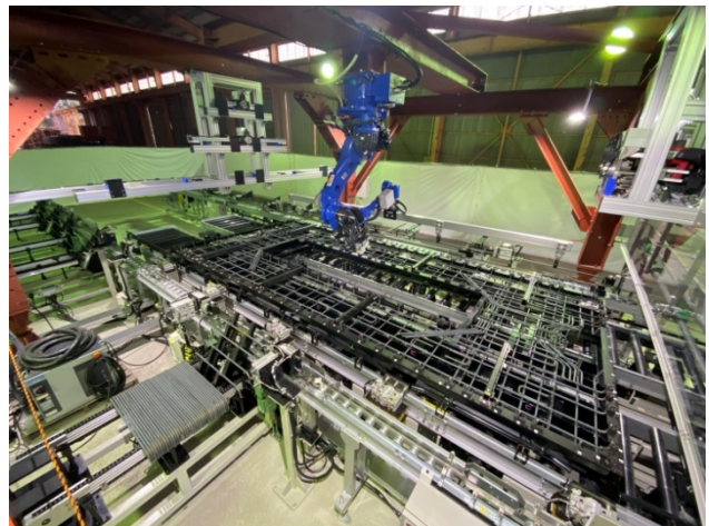
写真 3 鉄筋組立自動化システム「Robotaras」
