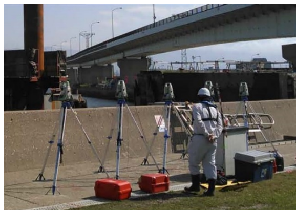
図-4 鋼管杭誘導状況
