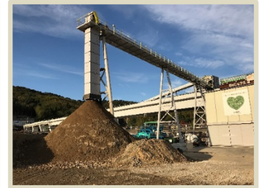
写真 5 ズリストックパイル
