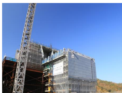
写真3 P6柱頭部（押し出し前）
