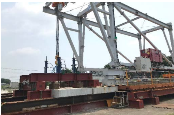
写真1 新設床版の搬入・架設作業
