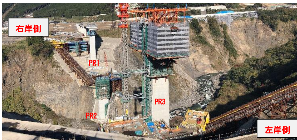
写真-2 右左岸のインクライン
