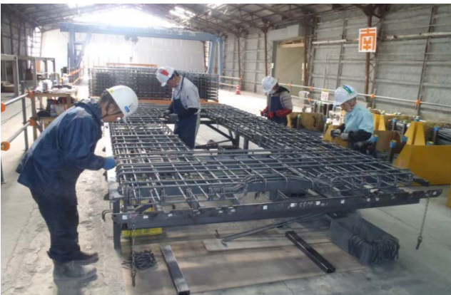
写真 1 手作業による鉄筋組立状況
