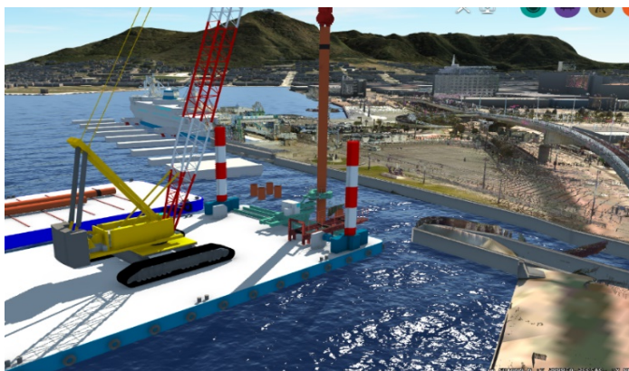
図-3 鋼管杭打設状況
