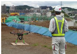
UAVレーザー測量
