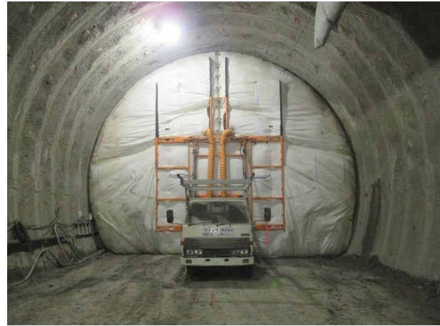
移動式発破防護バルーン
