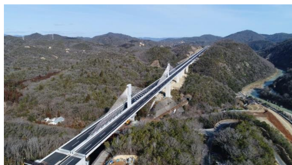
写真 2 生野大橋全景（完成）
