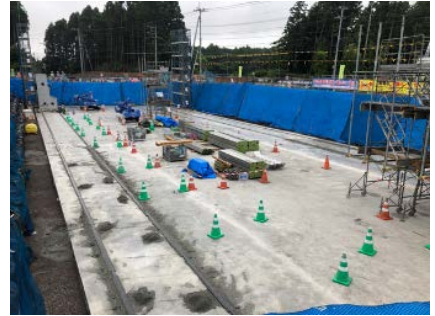
写真1 定規材設置状況
