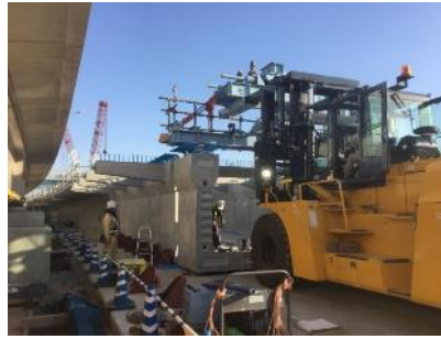
写真2 セグメント架設
