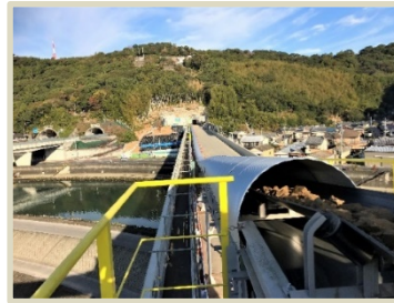
写真 4 ベルトコン設置状況 (橋梁部)
