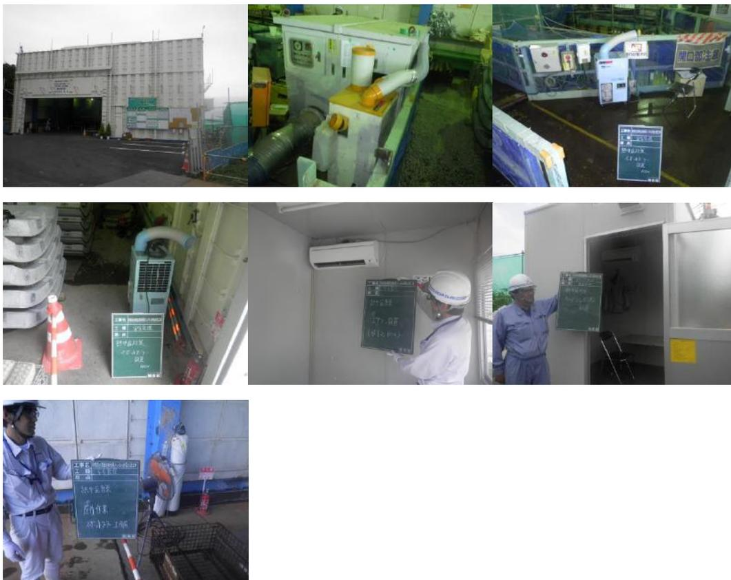
現場をハウスで覆うことにより夏は直射日光が当たらず、冬は冷風及び雪を凌げ、ハウス内はプラント設備の熱で快適温度を24時間保てた。
