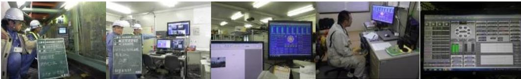
場内監視カメラ5台設置し、事務所・マンション・詰所から常時見られるようにした。また、掘進管理システム(ジャイロ、ジャベル)を構築しNET回線を通しどこからでも確認できるようにした。これらにより測量回数を軽減することができた。
