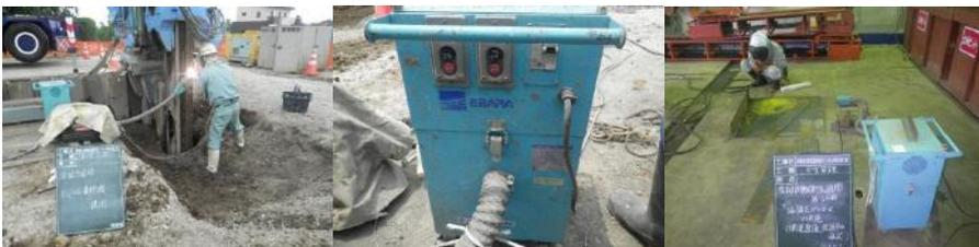
溶接作業には集塵機(ヒュームコレクター)を使用し溶接作業員以外の人もヒュームを吸い込まないようにした。
