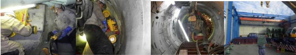
各所揚重装置設置。4.8t 吊り天井クレーン(早巻き装置付)、坑内電動ホイス、セグメント組立エレクター(微調整油圧ジャッキ装着)
