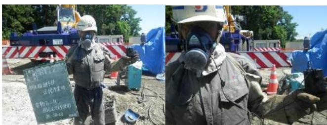
作業所内で作業に使用する防塵マスクは全て電動ファン付を支給しました。夏でも呼吸がしやすく快適であったと好評。
