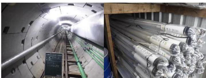
坑内照明にLEDを使用することで、従来と同じピッチで設置すると非常に明るくまた、発熱しないので坑内が高温にならず、過ごしやすい環境となった。
