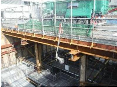
屋外作業でも構台下の日の当たらない場所や冬季の夕方作業に備えて照明の設置を行っている。常に照度を保つことにより、作業員が安全に通行・作業が出来るようになる。
