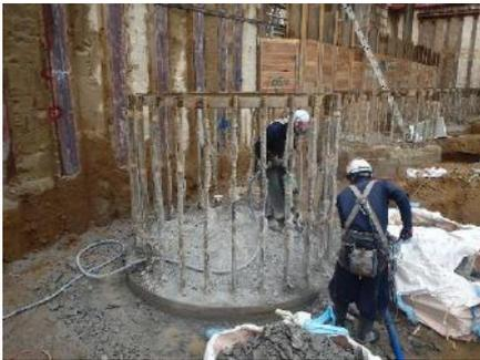
現場造成杭の杭頭研り作業は、杭周辺の床付けを正規のレベルで行った後で行うと無理な作業姿勢になってしまう。一旦、杭周辺の掘削を低めに設定して行い、研り作業の作業空間を確保した上で作業を行った。その後、正規レベルで床付けを行った。
