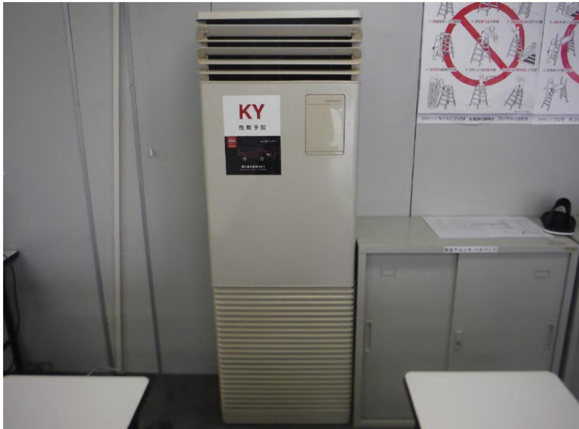
現場敷地内にある「打合せ室」、「作業員休憩室」、「喫煙室」、「トイレ(男女共)」、「シャワー室(男女共)」にそれぞれの床面積に見合った容量の冷暖房機器を設置し、各室の使用時に温熱環境を維持できるようにしている。また、夏期においては打合せ室の環境を現場稼動中は常に整えることにより、熱中症発症時の応急手当室としている。
