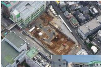
土工事中のダンプ動線及び場内の搬出入車両動線については敷き鉄板を敷設すると共に状況に応じて散水を行っている。それにより粉じんの飛散を防いでいる。
