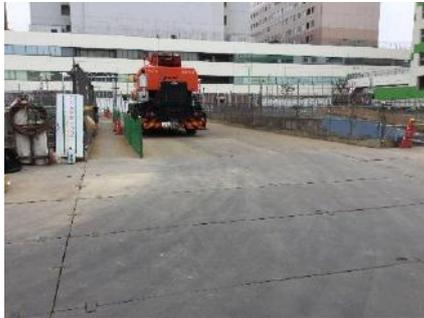
地下躯体工事中に設置する構台のレベルの見直しを検討し、当初の計画（1FL+1150 mm）から設定 GL（1FL-300）レベルに変更をする事により作業所内の段差の解消を行った。それにより作業員の重量物運搬時の負担軽減が実現された。
