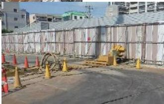
また、スパッツ(湿式タイヤ洗浄機)を設置し、場内外への土の流出を防ぐと共に粉じんの抑制に努めた。
