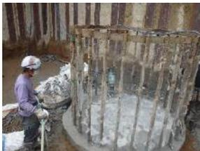
造成杭の杭頭研り作業に使用するコンクリートブレーカーには消音器を取付て騒音レベルの低下に努めた。騒音レベルの低下させることで、周囲で行なう作業の環境を整えた。
