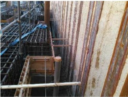
地中梁の外周の埋め戻し(流動化処理土)を数回に分けて行った。本来、外周側の型枠建込は足場上での作業となるが、埋め戻しレベルを調整することで足場上での作業を無くし、安定した作業空間の確保が可能となった。
