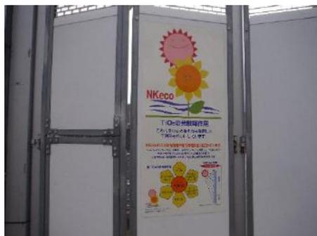
仮囲いの一部に光触媒を施したパネルを使用し、環境保全の一環としている。
