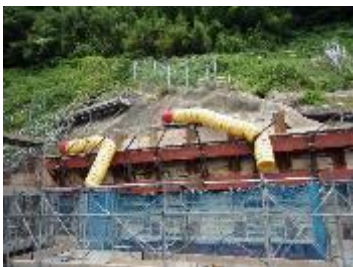
橋台設置送風機 φ500
