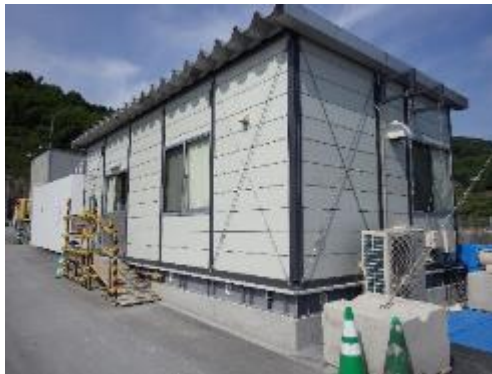
作業員休憩所外観
