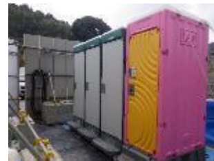
現場トイレ設置(男3、女1)
