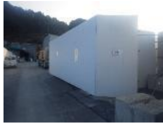
現場トイレ仮囲い(目隠し)
