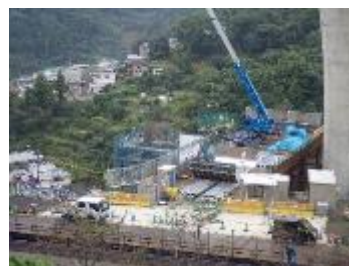
橋脚施工状況
