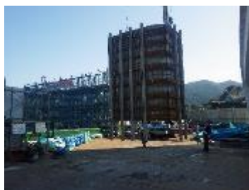
鋼製の大型型枠（8回転用）
