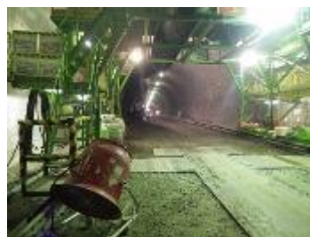
大型送風機(坑内)
