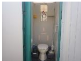
男性用(洋式便座、水洗、フラッパー機能、照明)
