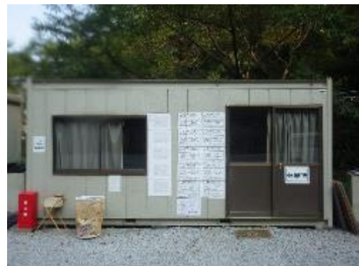
日見夢大橋作業員休憩所
