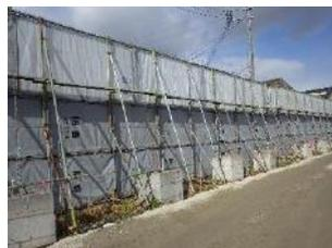
②現場外側に鋼板による仮囲いを行い、現場内側から防音シートによる二重の防音対策をしている。
