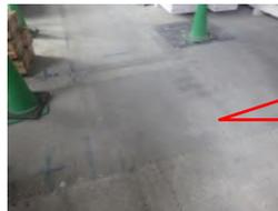
内部段差はAS舗装にてスロープ形状に変更。
