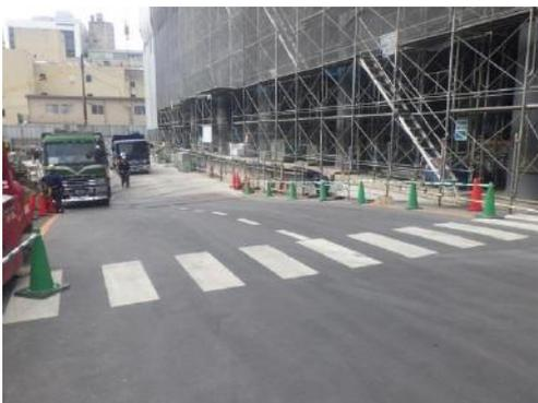
現場内の車輛通路は仮設アスファルト舗装とすることで粉塵飛散対策を図った。
