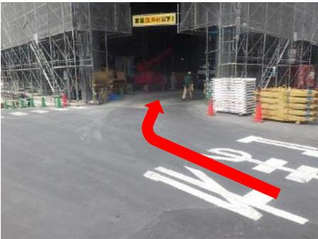
1ゲート→躯体入口→資材場重用仮設ELVまでのメイン搬入動線に対する無段差化を実施し、作業性の向上を図った。
