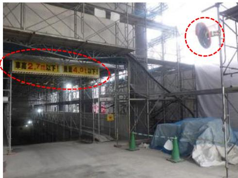
現場内において特に車両の通行が多い場所、接触が予想され、死角になりやすい場所には注意喚起看板とカーブミラーを設置して、現場内での接触事故防止に努めた。
