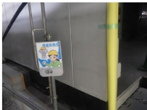
焦電型遠赤外線感知音声警報センサーを各所に設置して、注意喚起を行った。
