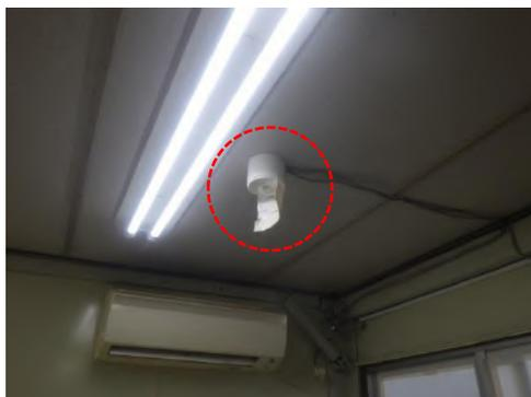
作業員の人数が多くなるにつれて、各所で電気の消し忘れが目立ってきた為、自動センサー式照明を設置した。現在、男子トイレ、安全通路、現場内階段照明にセンサーを採用している。消し忘れによるストレスが解消され、省エネにもなった。
