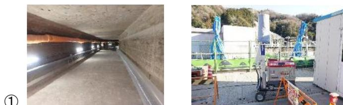
② 取水口内部での作業があるため、照度確保のための照明設備を設置している。また、屋外には発電機付きライトを常備し、必要な箇所で照度を確保している。
