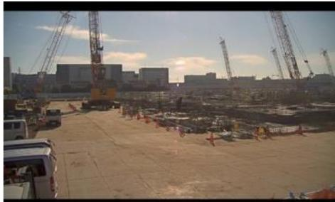
②現場に鉄板を敷き、土砂の表出を無くし、車両通行及び風散による粉塵を防ぐ。
