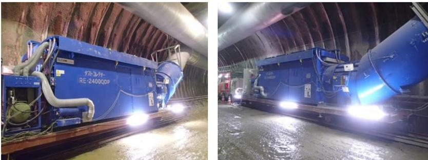
トンネル坑内に集塵機を設置し、トンネル内の空気環境に配慮している。
