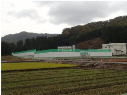
3mの万能板に加えて上部に防塵ネットを全周に設置し、粉じん対策をしている。
