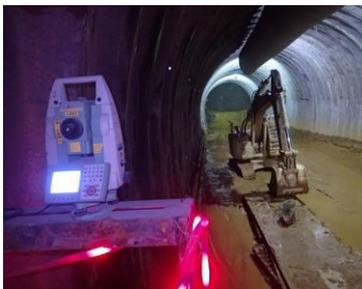
トンネル掘削の自動計測により、職員が毎回測量に行く必要がなくなり省人化が図られている。
