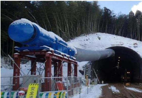
現場事務所と現場休憩所にエアコンを設置することによって適正な温度状況が維持されている。また、現場は坑口に送風機を設置し、トンネル坑内に送風することでトンネル坑内も適正な温度状況が維持されている。
