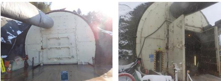
坑口に防音扉を設置することで、発破音及びトンネル坑内の騒音を抑制し音環境に配慮している。
