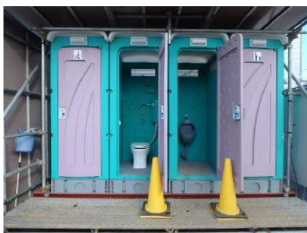
現場には水洗式トイレを設置。
