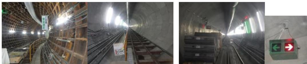
看板による安全通路の明示、信号機によるバッテリー離合時の明示を行っている。
