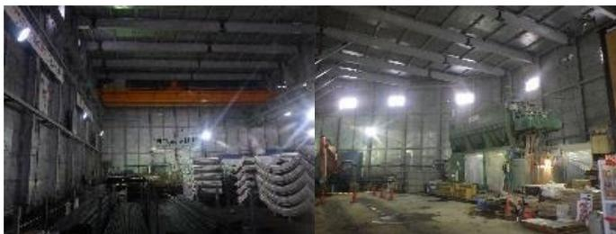
照明設備(水銀灯、LED 灯)を設置し、各所の作業環境にあわせて照度を確保している。
