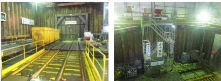
立坑下の作業床を無段差化している。吊荷作業時等のつまずき転倒防止となっている。昇降時は、頭上や安全带等に接しないように幅や高さを広げた昇降設備を設置している。
