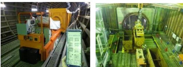
重量物運搬の負担軽減のため、坑内への資機材運搬にバッテリーロコを使用している。またリモコンにより、運転席に座らずとも遠隔操作することができる。遠隔操作できることにより、作業員の動線が少なくなり作業効率の向上と安全効果が確実にあがった。
