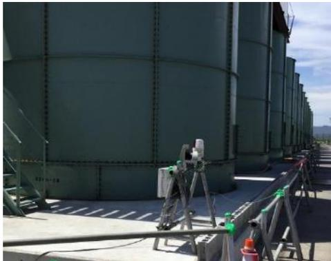
作業エリアの外周部付近で作業を行う際、クレーンのブームが万一場外側に近づいて行かない様、赤外線センサーで監視をしている。
