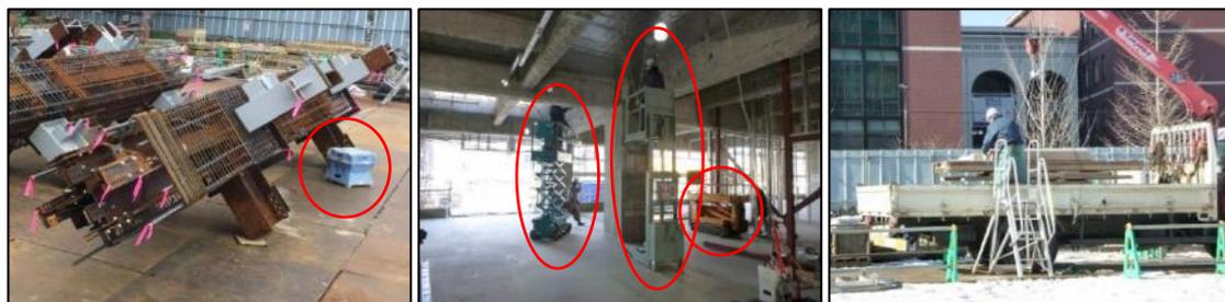
作業姿勢等を改善する為、作業高さに適した作業台や高所作業車を活用したり、トラックへの昇降専用の階段を使用。
