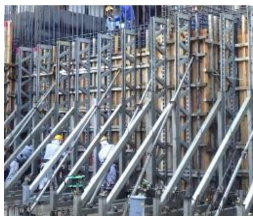
地下外壁システム型枠
