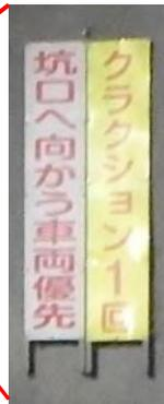
避難坑の非常駐車帯には看板でクラクション合図を徹底させるとともに、対向車の接近を赤外線で感知し、手前側のパトライトで表示し、点灯中に進入させないようにした。
