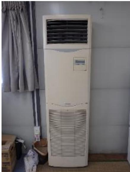
現場詰所内に設置された冷房。夏場は $30^{\circ}\text{C}$ を超えるため、30畳ほどの広さの現場詰所に左のような2台のエアコンを設置し、室温を $26^{\circ}\text{C}$ に保った。
