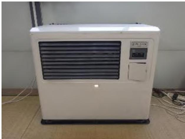
冬期に $-20^{\circ}\text{C}$ 近くになる現場の寒さ対策のため、30畳ほどの広さの現場詰所に左のような2台のストーブを設置し、室温を $22^{\circ}\text{C}$ に保った。
