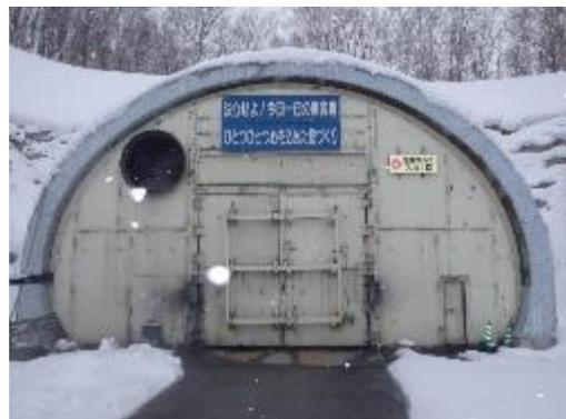
本坑坑口の防音扉。発破時などに扉を閉めることで坑外への騒音を防止した。
