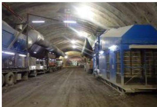
トンネル本坑内にメタルハライドランプを設置し、照度アップを行い照明による死角を極力減らし、安全な施工ができるようにしている。
