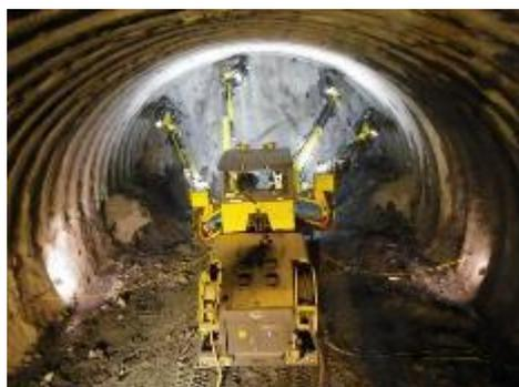
削孔に4ブームフルオートコンピュータジャンボを導入し、オペレーター1人に対応できるようにすることで省人化を進めた。
