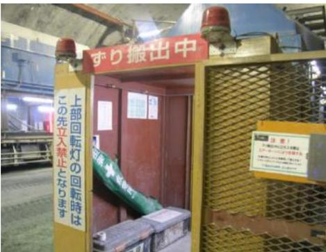
トンネル内のずり出し作業では本坑は点火場より切羽側は立ち入り禁止の表示とパトライトによる表示を実施。緊急事態での進入時はエアークーンにて全重機を止めてからの進入するルールを徹底した。
