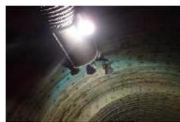
トンネル本坑内に処理風量 3000m<sup>3</sup>/min の集塵機を設置した。また換気設備として伸縮風管を使用し、発破後に切羽付近まで風管口を移動させるようにすることで、効率的な換気を可能にした。風管の先端にはライトがついており、切羽の照度を確保した。
