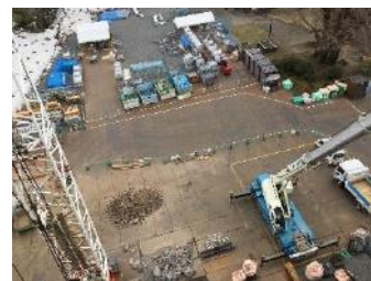
東側作業ヤード
