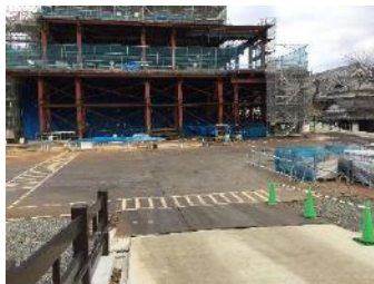
西側作業ヤード
