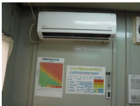
トンネル詰所設置状況
