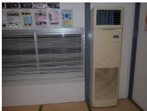
作業員休憩室設置状況
