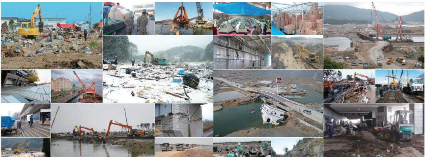
各地で大規模な処理プラントが設置され、災害廃棄物の破砕、分別、仮置、搬出等が行われた。
