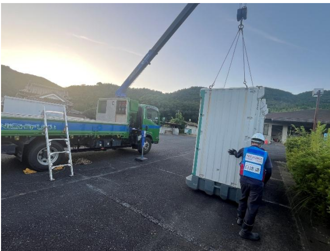
（二見コミセンへの仮設簡易トイレの設置）
