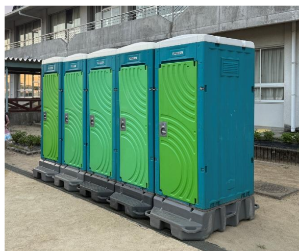
(竜北西部小学校への仮設簡易トイレの設置)
