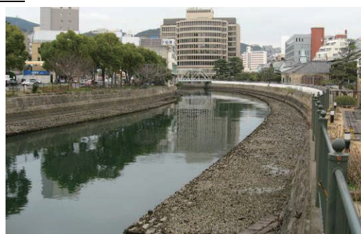
写真 2. 1. 27 中島川変流部護岸(右岸)
