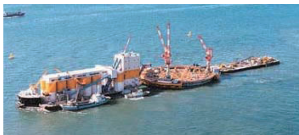
写真 2.2.1 明石海峡大橋主塔基礎 6)
