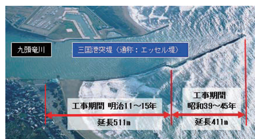
写真 2.1.16 三国港エッセル堤 7)
