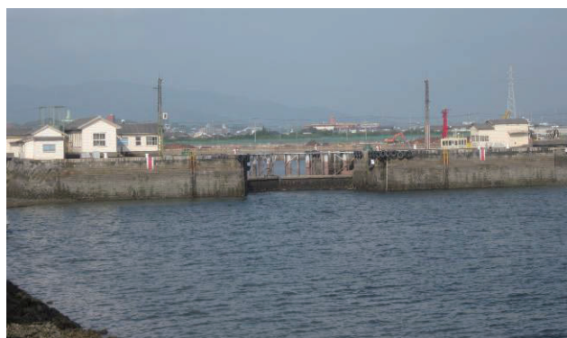
写真 2.1.25 三池港 船渠入口
