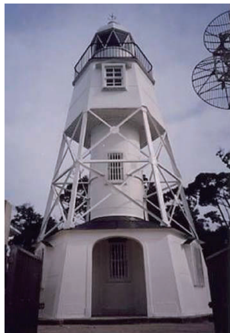
写真 2.1.14 姫埼灯台の現況 3)
