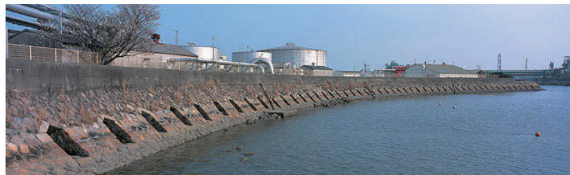
写真 2.1.11 四日市港旧港防波堤（潮吹き防波堤） 1)
