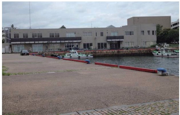
写真 2.1.24 南海岸物揚場
