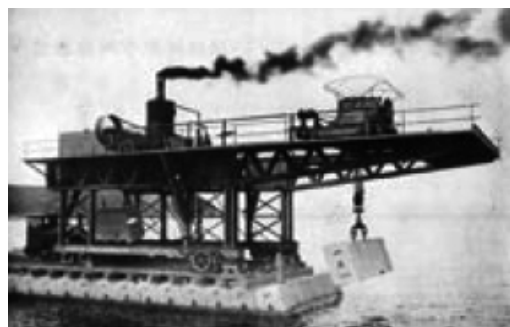
写真 2.1.4 積置機による斜塊の据付 2)
