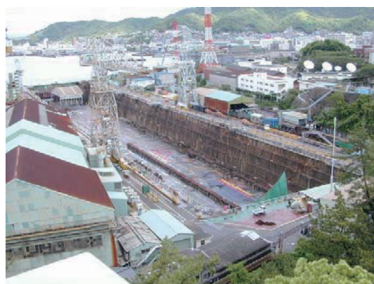
写真 2.1.21 第四修理ドック(旧第四船渠) 5)
