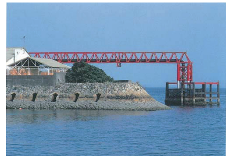
写真 2.1.12 防波堤先端部 1)
