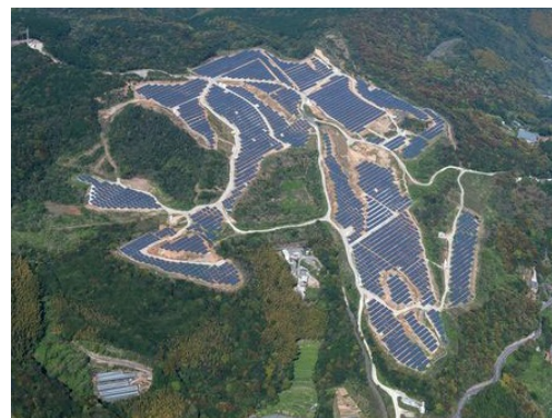
写真-1 設置完了全景
