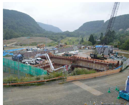
写真-1 発電所基礎施工状況
