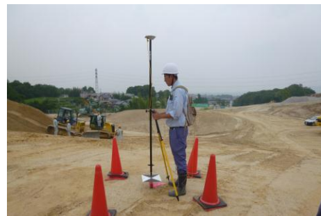
図一 3 精度確認状況
