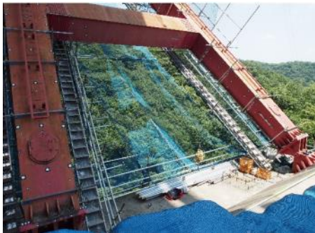
写真-1 現場カメラ計測状況（方杖基部）
