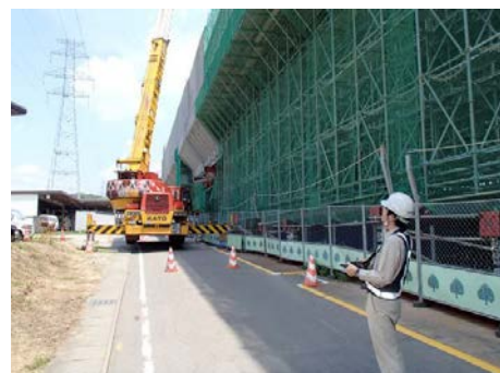
タブレットを使用した現場での監視状況
