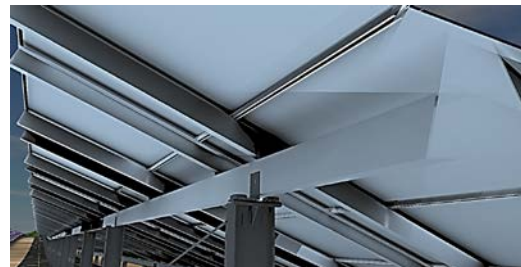
太陽光発電パネル裏面構造詳細
