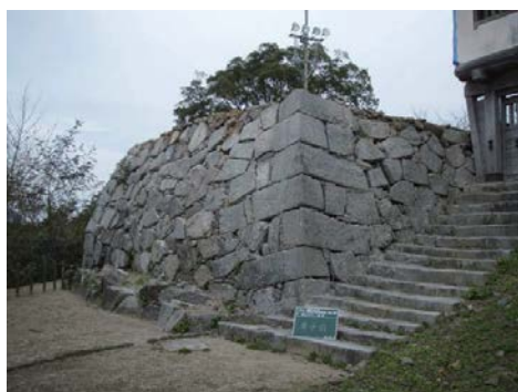
図1 石垣修復前状況
