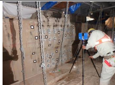
写真-1 3Dレーザースキャナ計測状況
