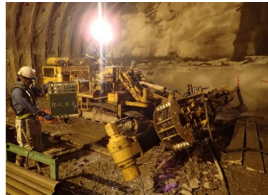
写真-1 切羽前方地山調査状況
