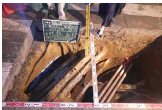
図 1 埋設物状況（試掘）
