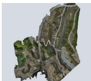
出来形進捗確認
