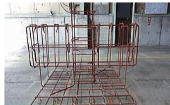
全鉄筋で準備した鉄筋組立教材
