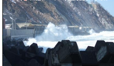
写真①（既設トンネル終点側抗口状況）
