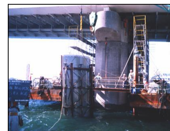
【大規模なもの(写真左)は4～8分割、小規模なもの(写真右)は2分割で施工】
