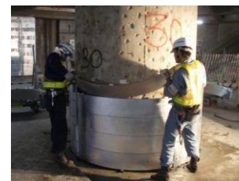
【重機が使用できない箇所の補強を分割・軽量化して人力で施工】
