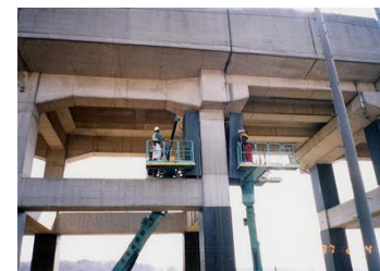
【固定足場の代わりに高所作業車を用いて施工】
