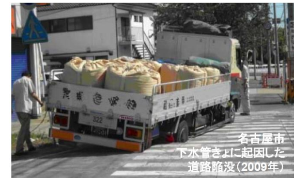
【下水道管の崩壊による道路の陥没事故】
