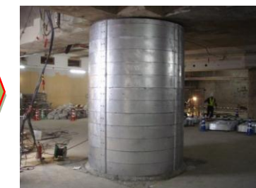
【重機が使用できない箇所の補強を分割・軽量化して人力で施工】
