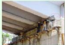
目視、打音検査
