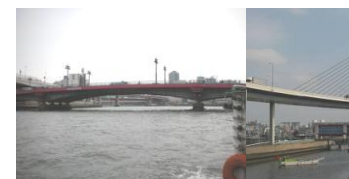
【大規模なもの(写真左)は4～8分割、小規模なもの(写真右)は2分割で施工】
