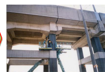
【固定足場の代わりに高所作業車を用いて施工】
