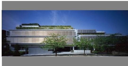
外部可動ルーバーにより熱負荷を低減
