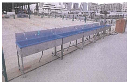
現場の手洗い場所の増設
