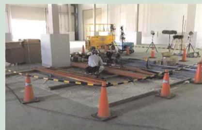
工事エリアの区画を設定して作業
