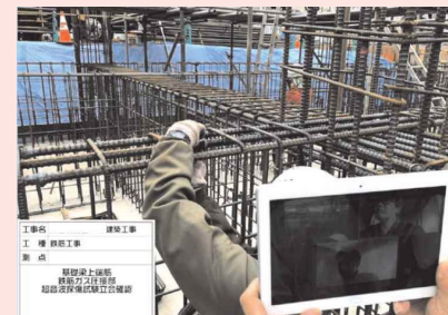
Webカメラを利用した遠隔検査
