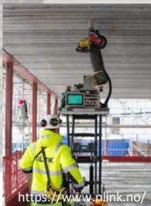
BIMモデルの3D情報をロボットの制御などに活用し、ロボットによる施工や施工管理を行う
