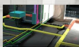
ARにより投影されるモデルに合わせて、図面レスで施工
