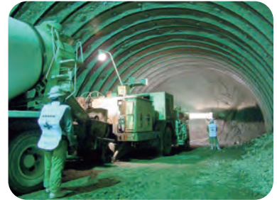
吹付け施工状況
