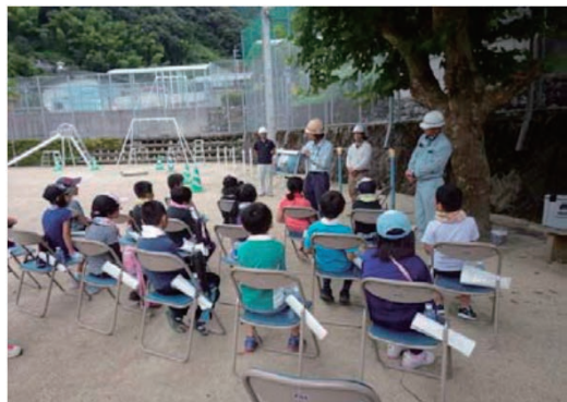
橋梁補修工事 体験学習
