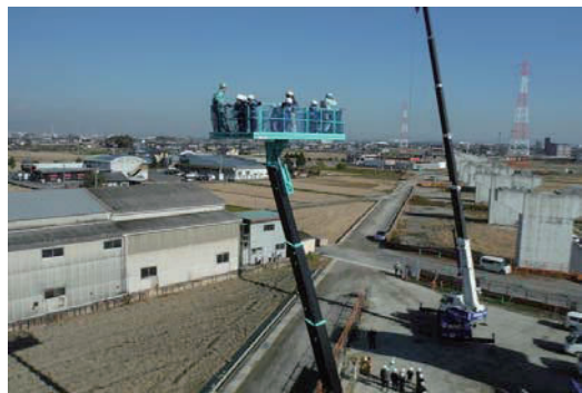
杭瀬川橋現場見学会開催
