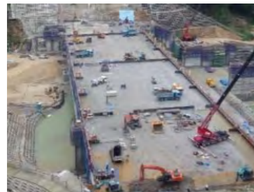
ダム工事における転圧施工状況
