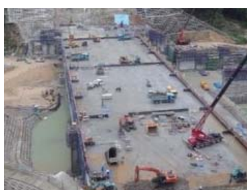
ダム工事における転圧施工状況
