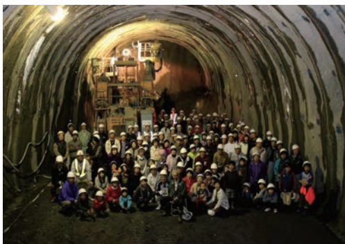
面谷トンネルの現場見学会
