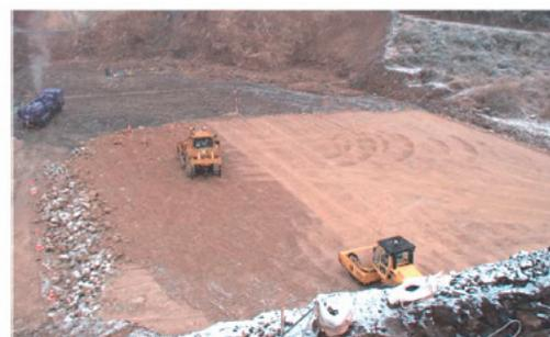
図-2 GNSS 締固めシステム
