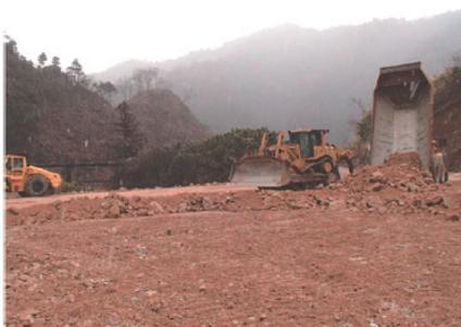
図-1 GNSS 敷均し管理システム
