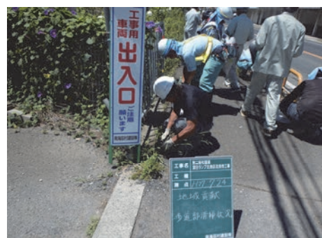
工事現場付近の国道歩道部の草刈
