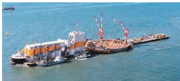
写真 2.2.1 明石海峡大橋主塔基礎 6)
