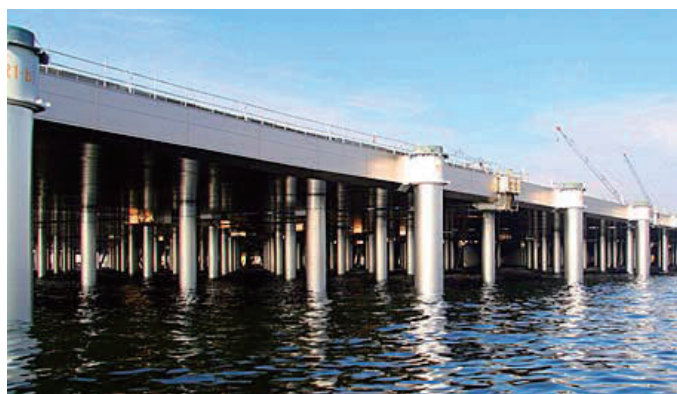
写真 2.2.2 羽田空港 D 滑走路の栈橋部 6)
