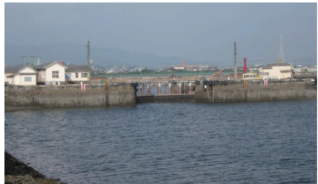
写真 2.1.25 三池港 船渠入口
