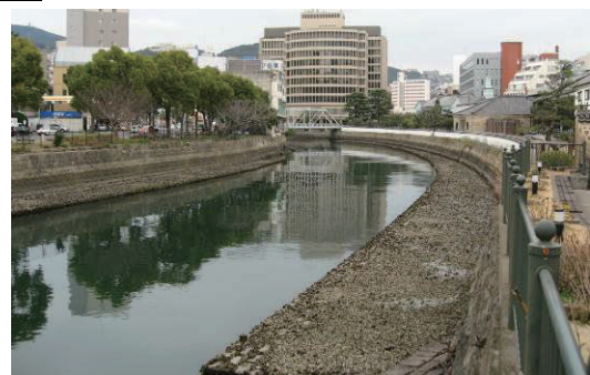
写真 2. 1. 27 中島川変流部護岸(右岸)
