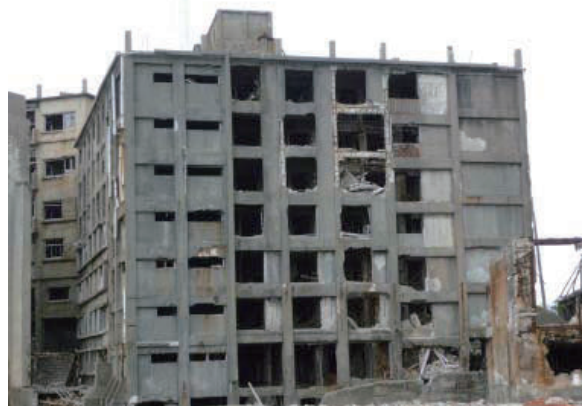
写真 2.1.33 30号棟アパート（RC造）
