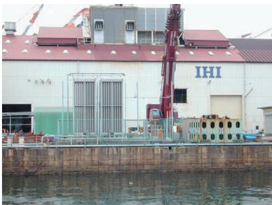
写真 2.1.20 呉事業所繫船堀北護岸 4)
