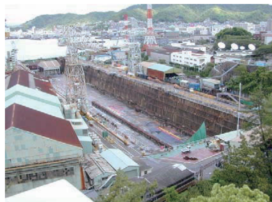
写真 2.1.21 第四修理ドック(旧第四船渠) 5)
