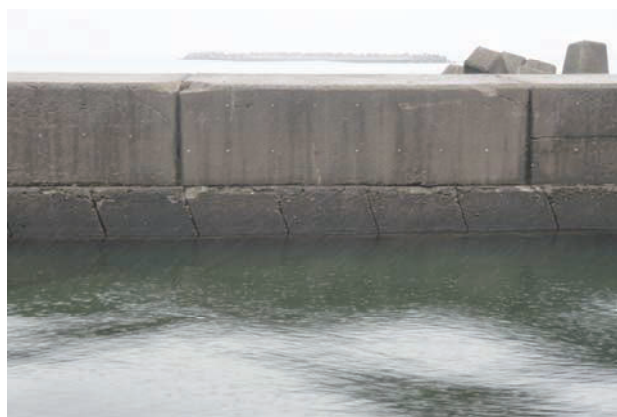
写真 2.1.2 北防波堤断面(コパンブロック工法)
