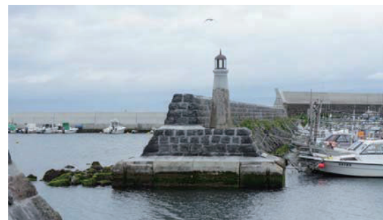
写真 2.1.6 函館漁港 船入澗防波堤
