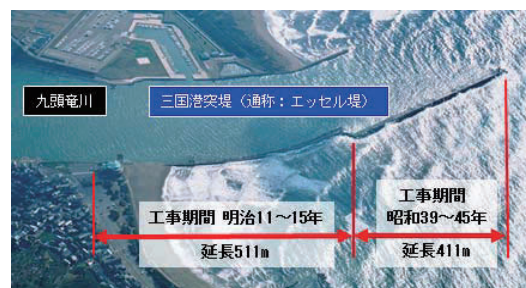
写真 2.1.16 三国港エッセル堤 7)
