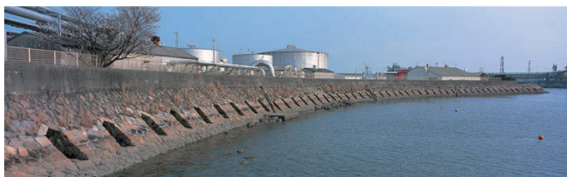
写真 2.1.11 四日市港旧港防波堤（潮吹き防波堤） 1)
