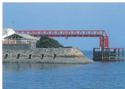
写真 2.1.12 防波堤先端部 1)
