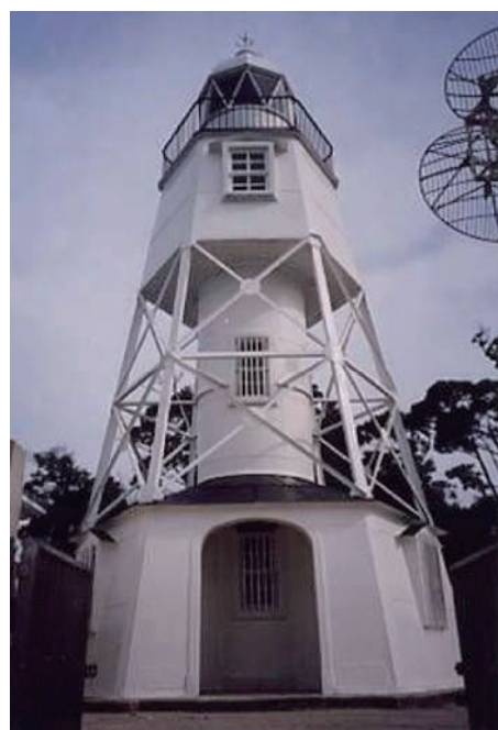
写真 2.1.14 姫埼灯台の現況 3)
