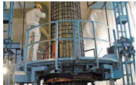
写真 2.1.8 柱の耐震補強 (PC 鋼より線巻き付け) 3)
