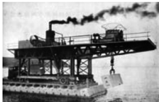
写真 2.1.4 積置機による斜塊の据付 2)
