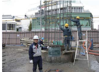
鉄筋かご建込状況
