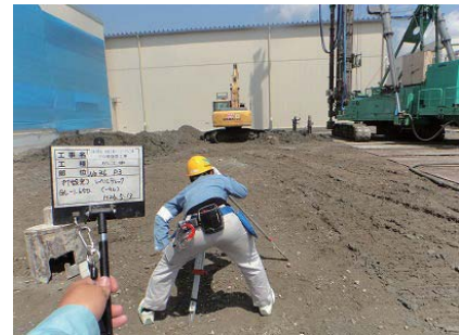
PHC杭レベル確認
