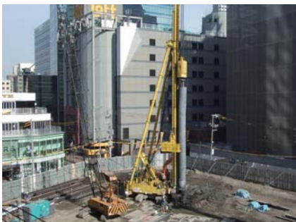
場所打ちコンクリート杭施工状況
