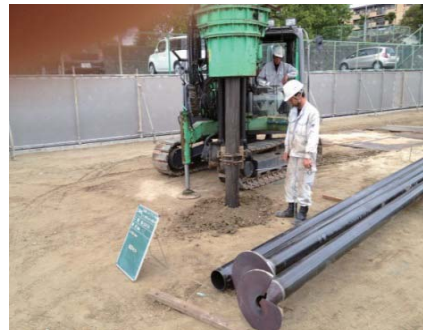
鋼管杭施工状況 1)
