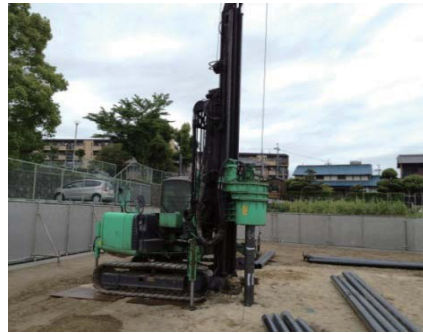
鋼管杭施工状況 1)
