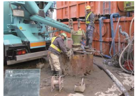
コンクリート打設状況
