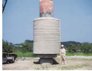
先端拡大根固部写真
