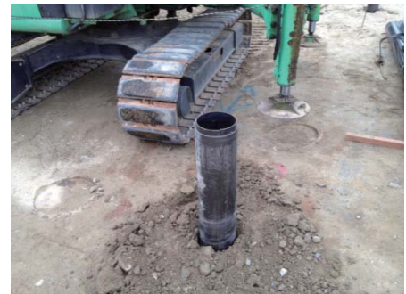
鋼管杭施工完了 1)
