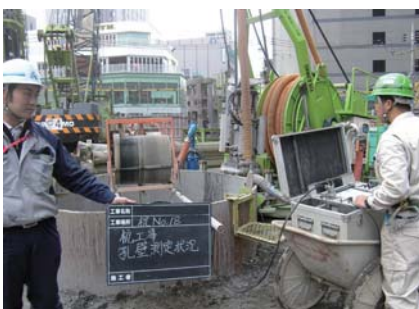
孔壁測定状況
