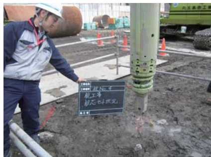
杭芯セット状況
