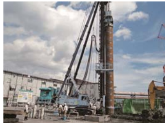
先端拡大根固工法施工状況
