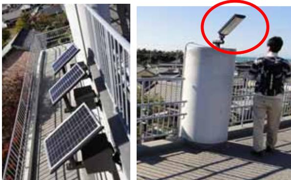
写真 5.5.5 太陽光発電式照明設備
