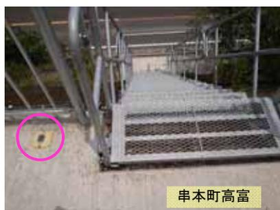
写真5.4.8 ソーラー式誘導灯（埋込型）
