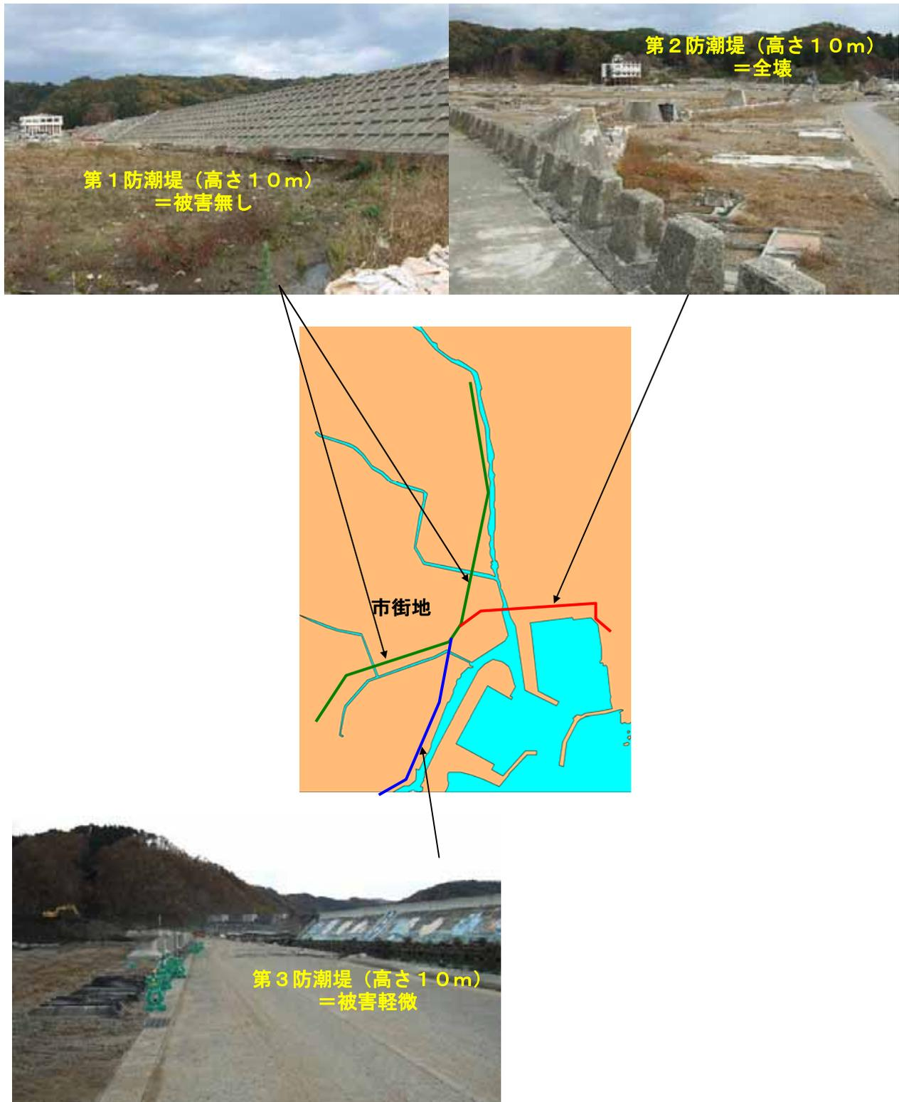
図 3.3 田老地区の防潮堤配置と被害状況
