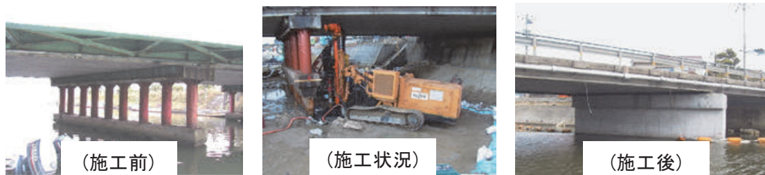
写真-1 工事事例 国道9号差海橋補強工事
