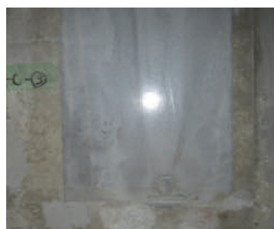
写真-5 補強完了
