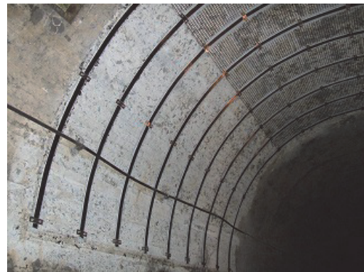
設置完了 (側壁部)
