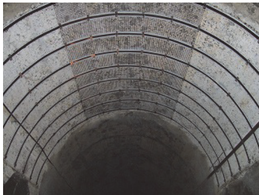
設置完了 (天端部)
