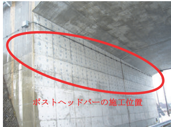
橋台への施工状況
