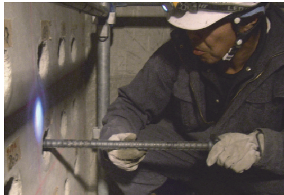
ポストヘッドバーの挿入状況
