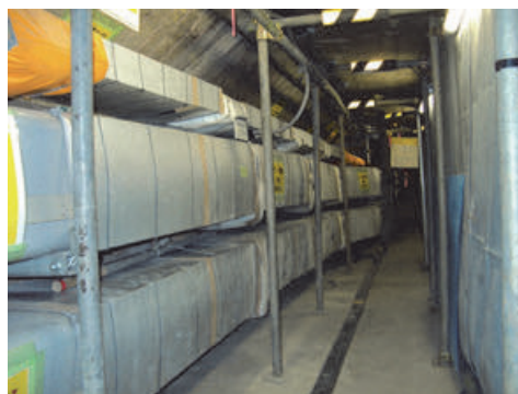
写真-1 共同溝内部の状況
