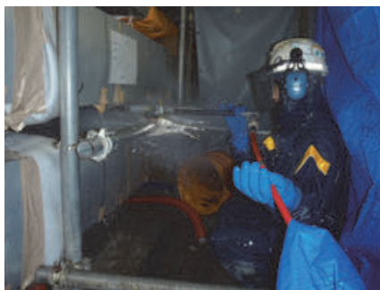
写真-2 高圧水による切削状況
