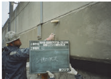
④シート貼付け
