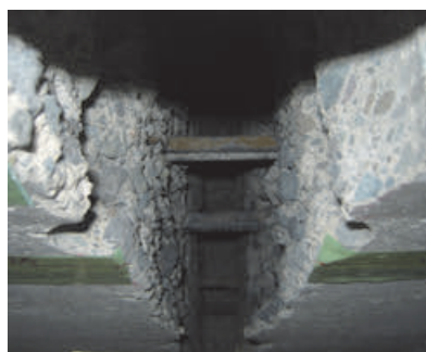
写真-3 切削完了
