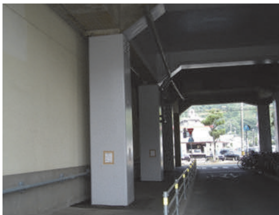
写真-1 壁が隣接している箇所の事例 (壁を存置したまま施工)
