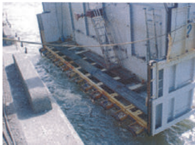
(a) 函体設置状況
