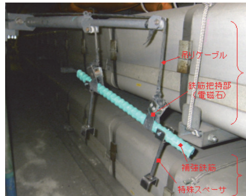
写真-2.2 鉄筋挿入装置
