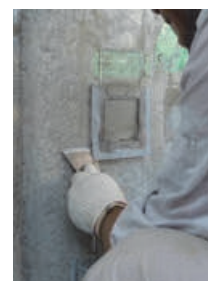
養生・仕上げ
