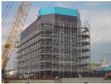
(a) 鋼製函体陸上仮組状況
