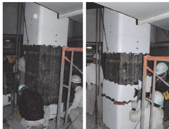
写真-2 柱上部に極端に離隔がない事例 (下部で組立てて吊上げ)
