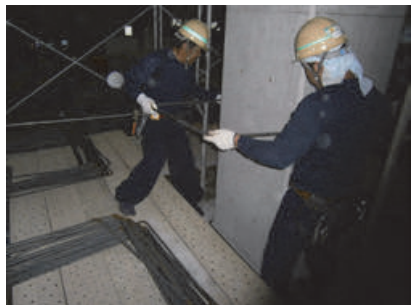
写真-2.2 普通鉄筋の差込み状況
