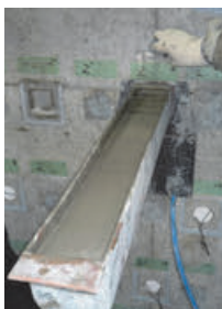
養生蓋の設置
