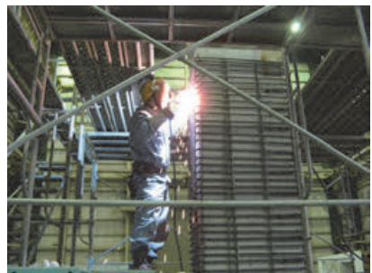
写真-2.4 フレア溶接状況
