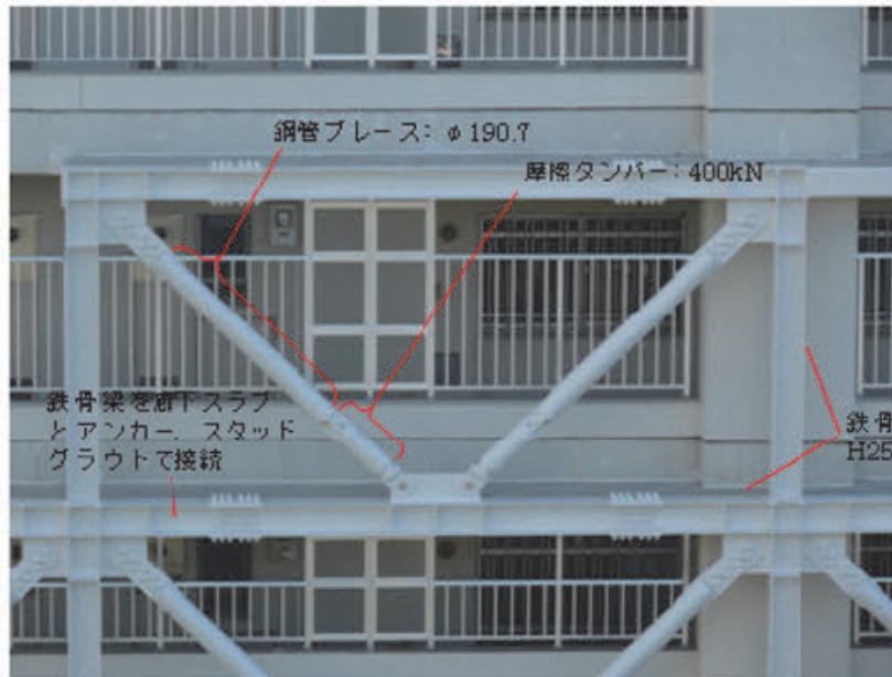
制震ブレース工法
