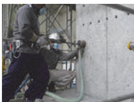
レッグハンマードリルによる削孔
