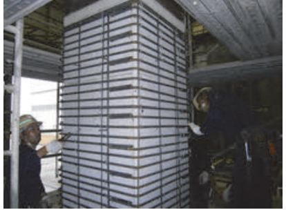
写真-2.3 普通鉄筋の組立状況
