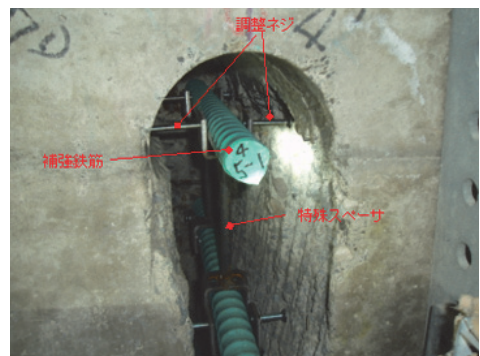
写真-2.3 特殊スペーサーによる補強鉄筋の支持
