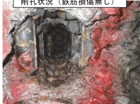
試験施工による モルタル充填状況確認
