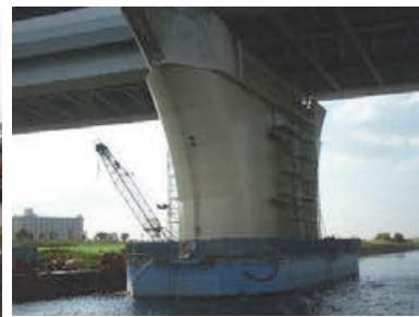
(c) 函体設置完了
