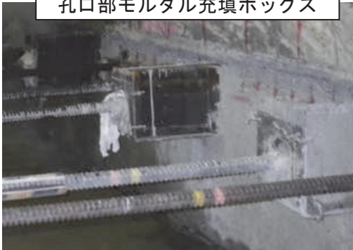
鉄筋挿入固定完了
