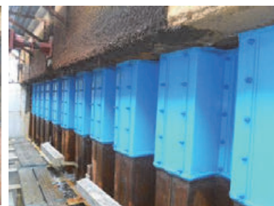
(c) 鋼矢板防食カバー設置後
