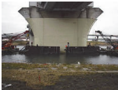
(b) 函体設置状況
