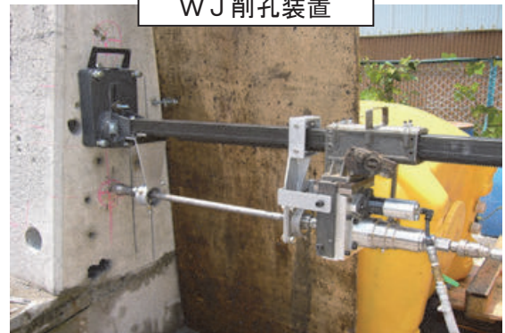
削孔状況（鉄筋損傷無し）
