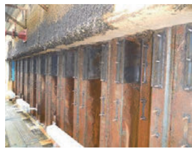
(b) 鋼矢板岸壁ドライアップ後
