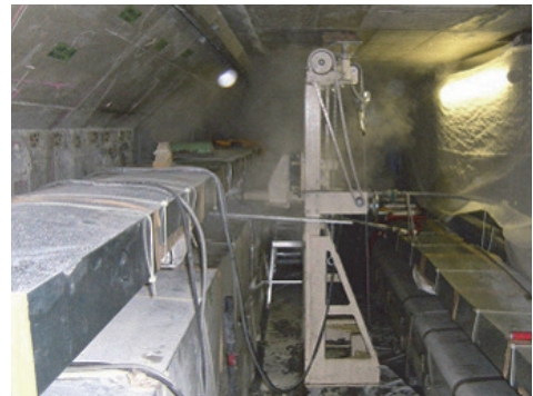
写真-2.1 スリット切削状況
