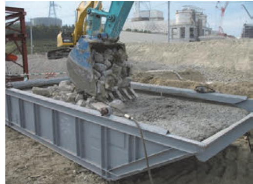
粗粒材混合状況
