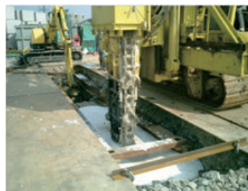
AWARD-Demi 工法の施工状況
