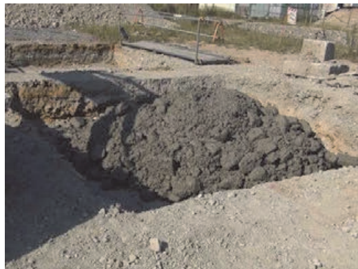
粗粒材混合体の打設
