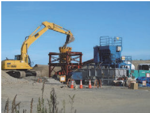
ランダム流動体製造プラント
