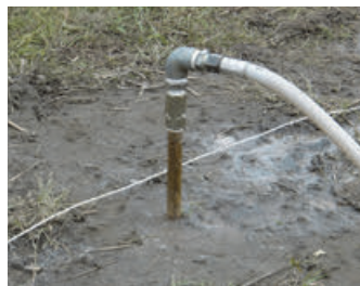
注入孔 (貫入ロッド)
