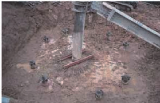
写真-7 杭打設完了
