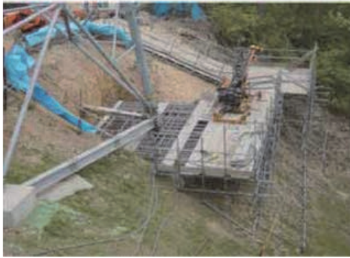
写真-5 資機材運搬状況
