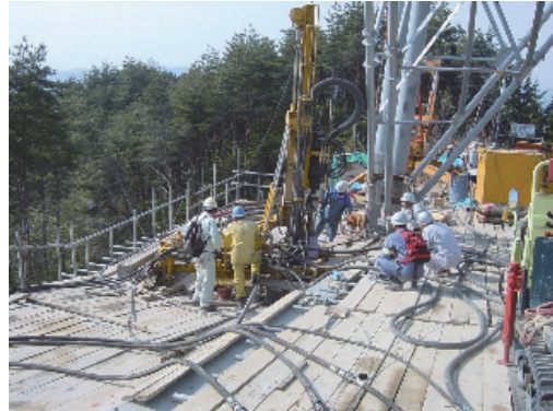
写真-6 施工状況
