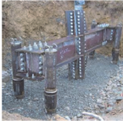
写真-2 鋼材の梁による鋼管杭の定着
