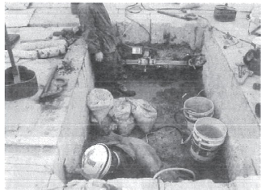
写真-3 水平コアドリルの削孔状況
