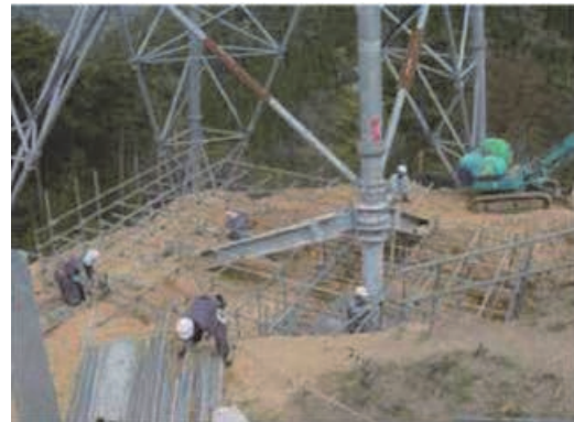
写真-4 施工状況
