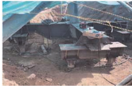
写真-8 鋼製部材接続
