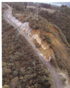
写真-1 NY81 地点の状況
