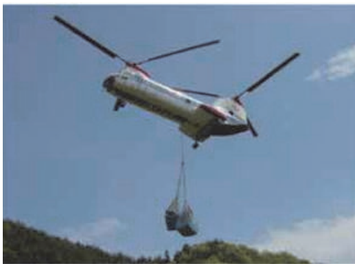
写真-3 資機材運搬状況
