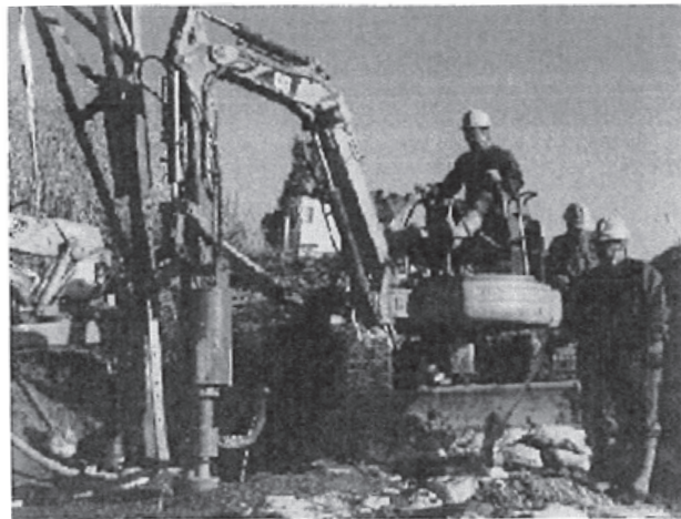
写真-3 小口径鋼管杭の打設状況
