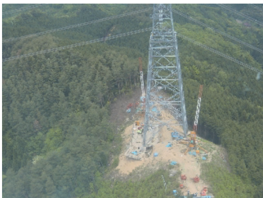
写真-1 施工状況全景
