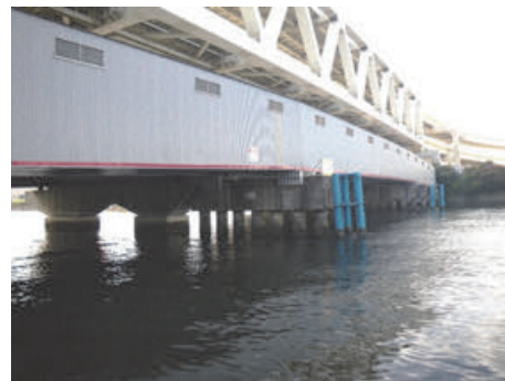
写真-1 電力用専用橋
