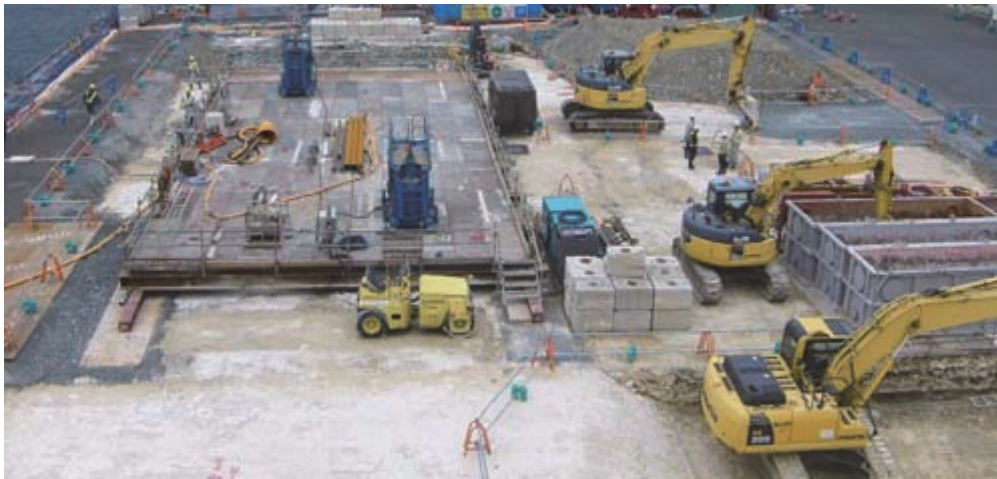
写真-1 施工状況写真
