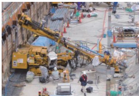
写真-1 工事状況
