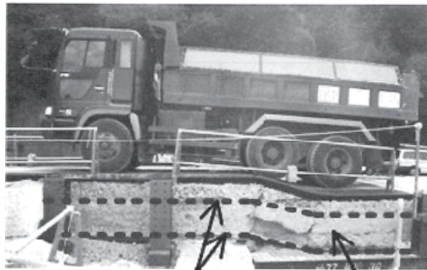
ジオテキスタイル セメント安定処理土
