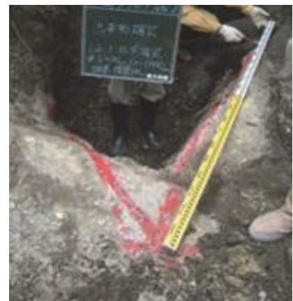
写真-1 地盤改良体の半径測定
