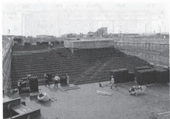
写真-1 軽量盛土施工状況
