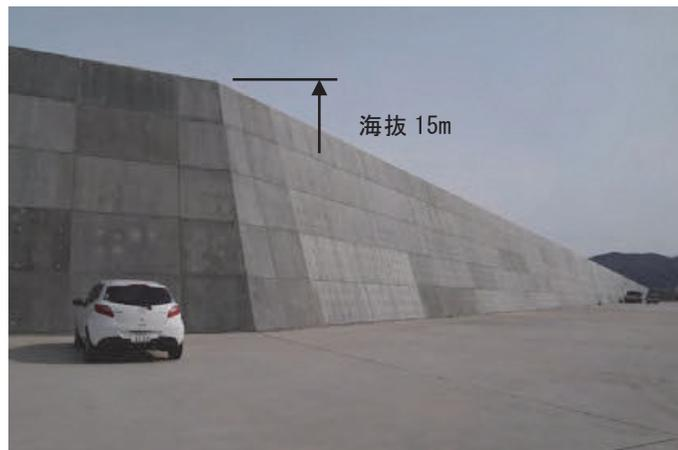
写真-3 3号機北側の防波壁(完成)
