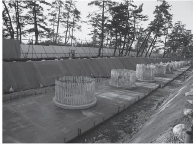
写真-1 場所打ち杭の施工状況（杭頭処理後）
