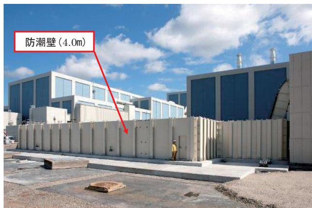
写真-1 1号機取水槽 防潮壁完成
