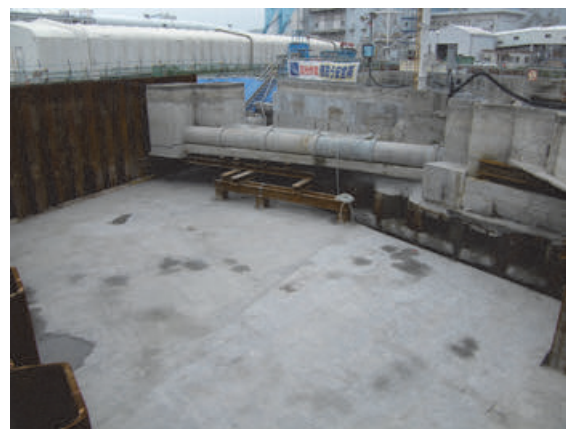
写真-3 HVFC 仕上がり状況
