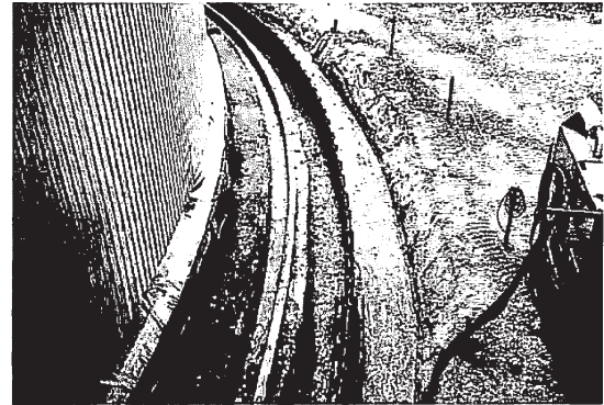
写真-4 鋼矢板打設完了状況
