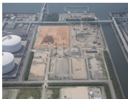
写真-1 施工時全景
