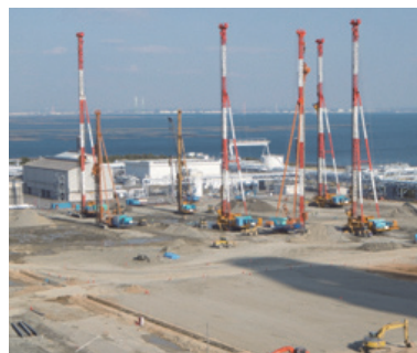
写真-2 タンク部施工時
