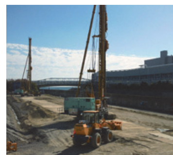
写真-3 護岸部施工時
