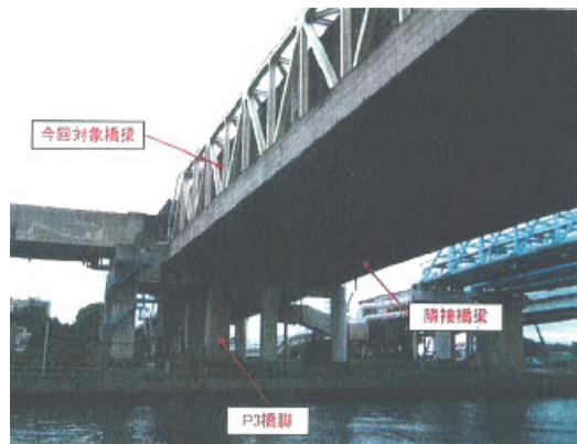
写真-1 LNG 受入配管水路横断橋
