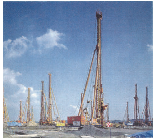
写真-2 施工状況
