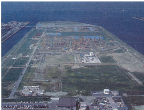
写真-1 施工状況全景
